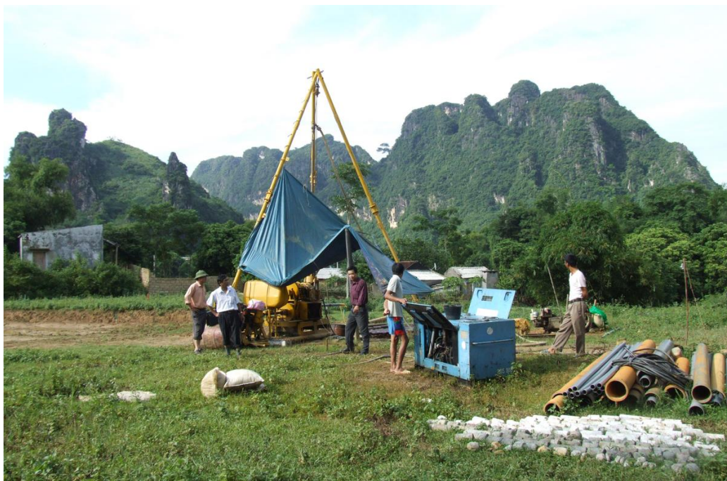
Khoan thăm dò nước ngầm tại Lương Sơn Hòa Bình
